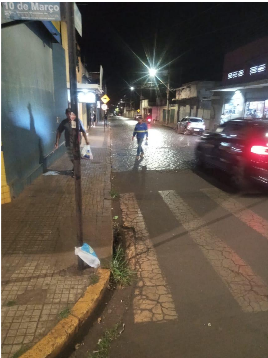
Via com luminárias modernizadas
