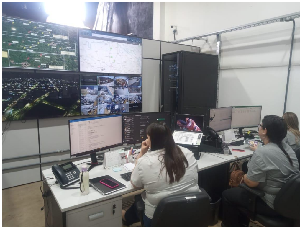
Centro de Controle Operacional
