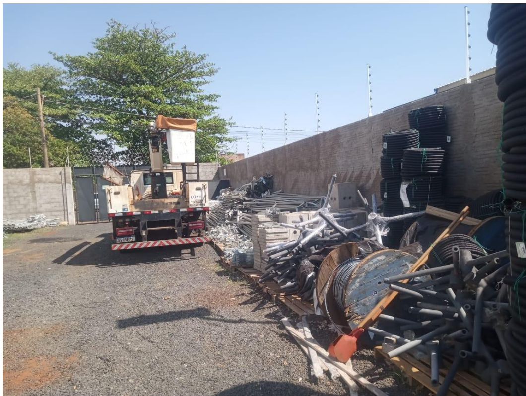
Depósito de Materiais
