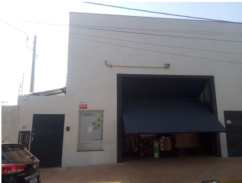
Fachada – Centro de Controle Operacional
