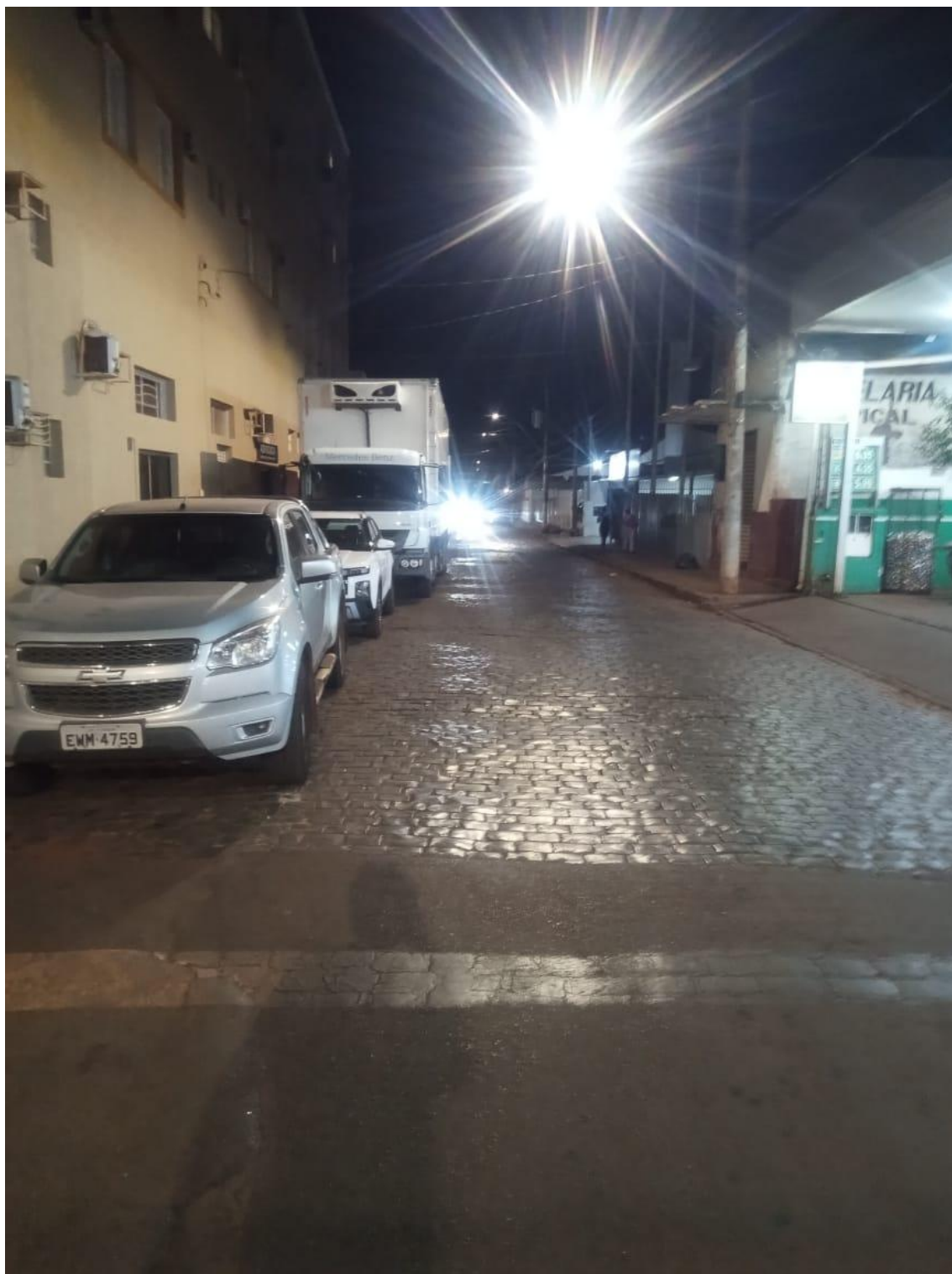
Via com luminárias modernizadas
